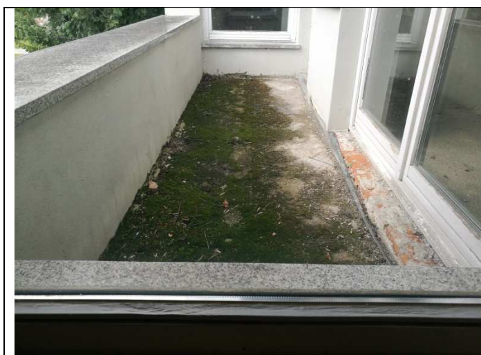
11 Widok loggii na I piętrze budynku
