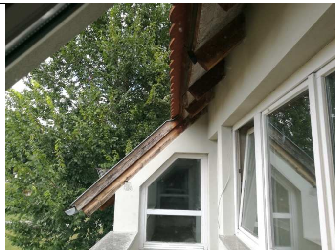
15 Widok okapu dachu nad loggią
