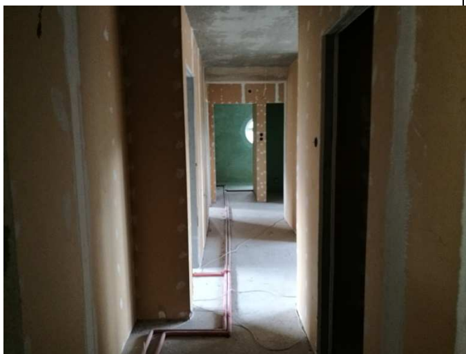
14 Widok ogólny zabudowy w obrębie I piętra
