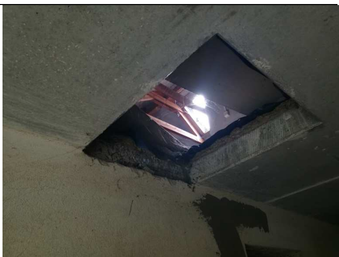
18 Strop płytowy nad I piętrzem
