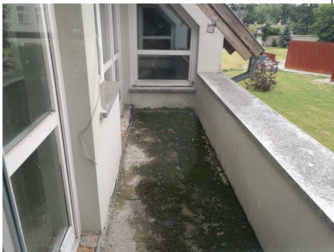
10 Widok loggii na I piętrze budynku
