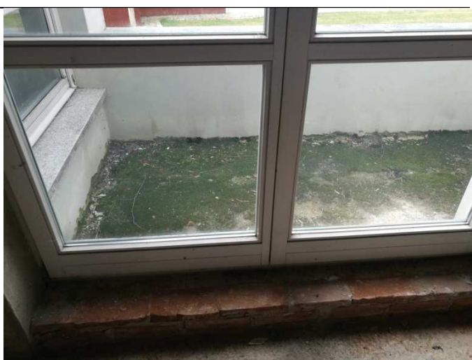
12 Widok loggii na I piętrze budynku
