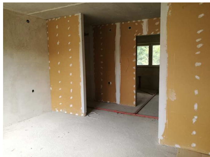
13 Widok ogólny zabudowy w obrębie I piętra
