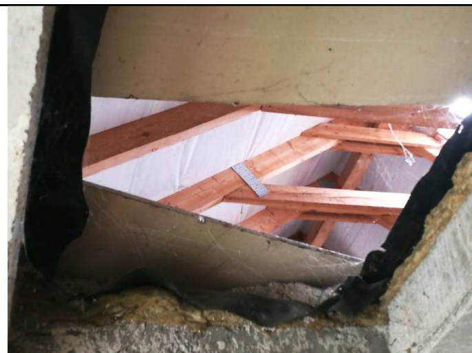
7 Widok fragmentu więźby dachowej
